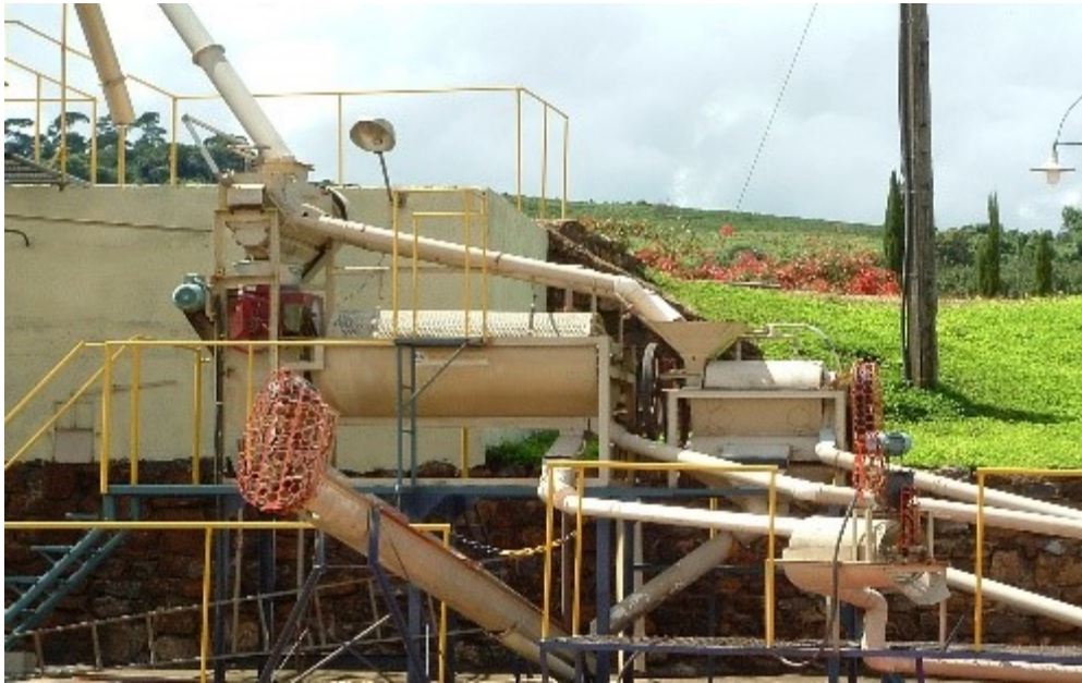
Vista do tanque e Cilindro
